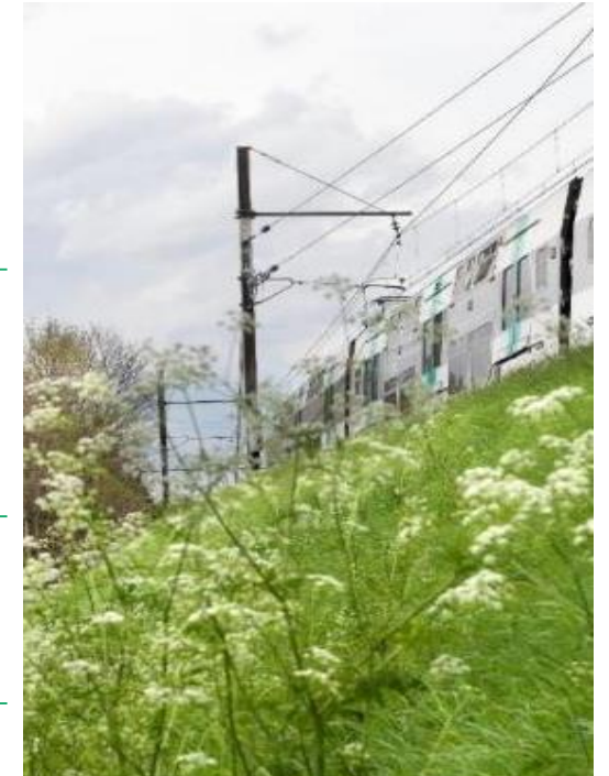
ECO-CONCEPTION POUR REDUIRE L'IMPACT A TRAVERS LE CYCLE COMPLET DE FABRICATION, D'EXPLOITATION ET DE FIN DE VIE
